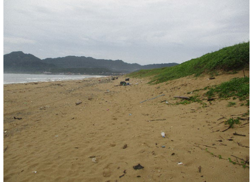
■ 舊社 2 號樁（南側）（111.6.9）
