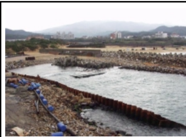
照片 1.1-4 進水口防波堤及重件碼頭工程 (北堤工程)
