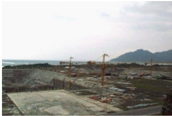
圖 1.1-1 一號機廠房區廠基開挖作業
