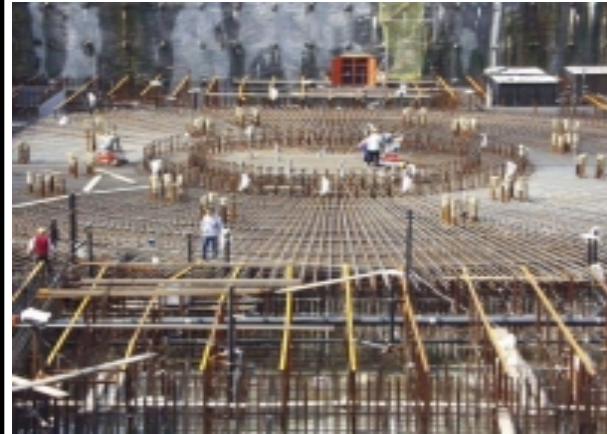
照片 1.1-2 反應器廠房施作情形
