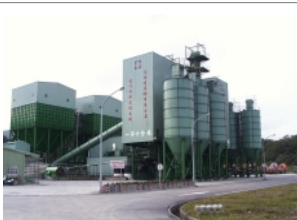
照片 1.1-3 混凝土製造供應工程
