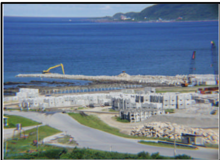
照片 1.1-3 進水口防波堤及重件碼頭工程 (南堤完成段)
