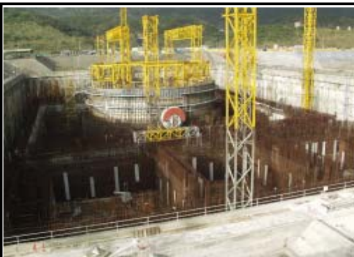
照片 1.1-1 一號機核島區廠房結構工程
