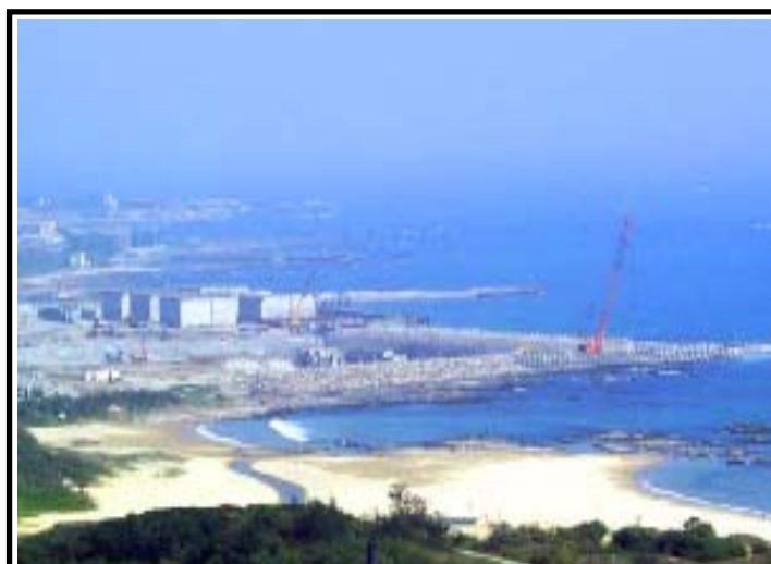
照片 1.1-4 進水口防波堤及碼頭工程
