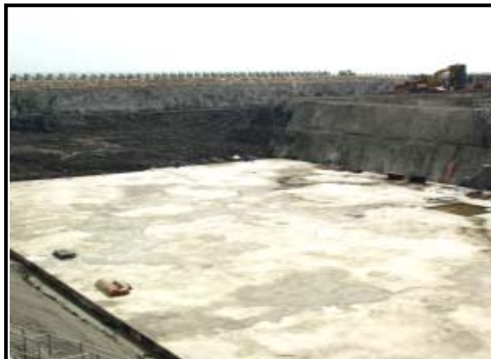
照片 1.1-2 循抽水機房及碼頭工程
