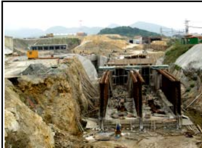
照片 1.1-2 進水口暗渠施工現況
