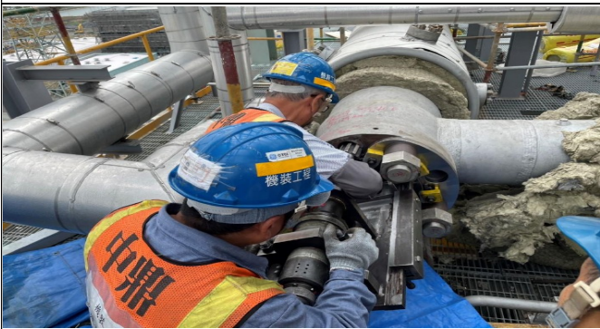
主發電設備工程 設備安裝
