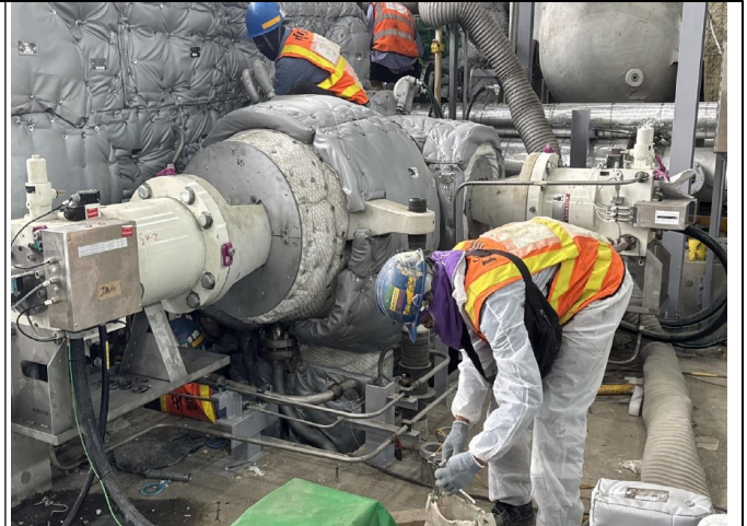
主發電設備工程 設備安裝
