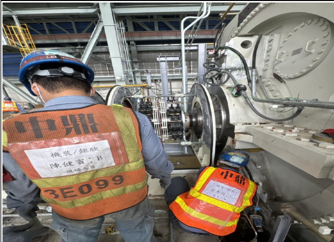
主發電設備工程 設備安裝
