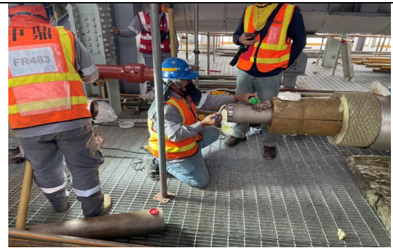
主發電 SS 設備工程 設備安裝
